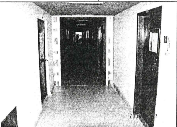
Foto 32 – Vista do corredor do 1º pav
