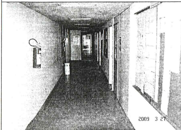
Foto 23 – Vista do corredor 3º pav
