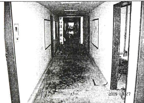
Foto 13 – Vista do corredor do 4º pav
