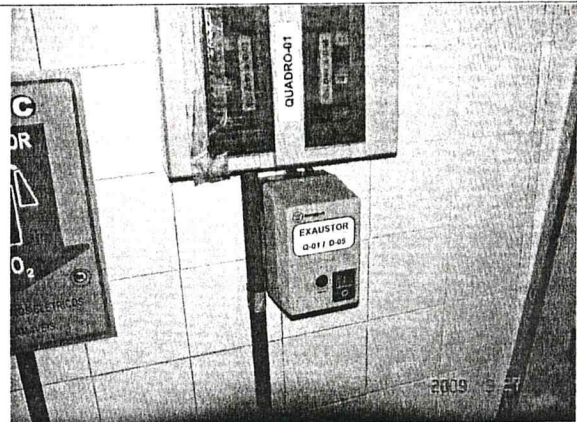
Foto 42 – Detalhe de segurança 1º pav
